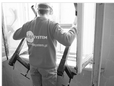
1 Montaż konstrukcji nośnej do ściany podokiennej
