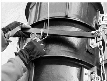
3 Zapięcie orczyka do elementu zasypowego
