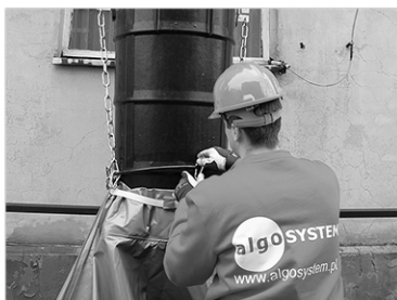
5 Zapięcie obręczy mocującej i planki na kontener
