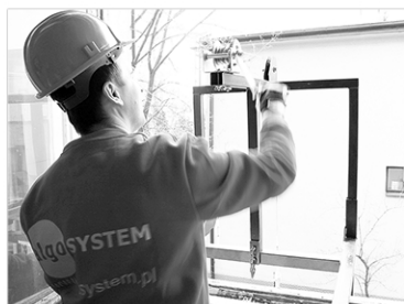
2 Mocowanie stojaka montażowego i wciągarki z orczykiem.
